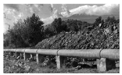
Fig. 55 - Sostituzione acquedotto Maraulì con tubi di mm. 500
